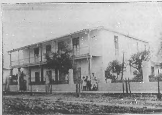
CENTRAL ZAZA. — Casa de vivienda de los señores Marqueses de Zulueta, propietarios del Central.
